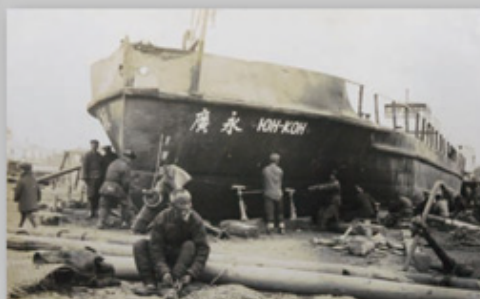
杉本恒記旧蔵記録：「ドック内の修繕作業風景」1935年5月
